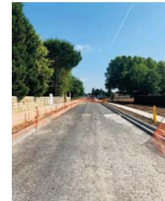
Ce nouvel aménagement permettra de sécuriser les déplacements grâce à une route départementale réduite à 5,80m permettant néanmoins une circulation en double sens et obligeant de ce fait les véhicules à ralentir.
